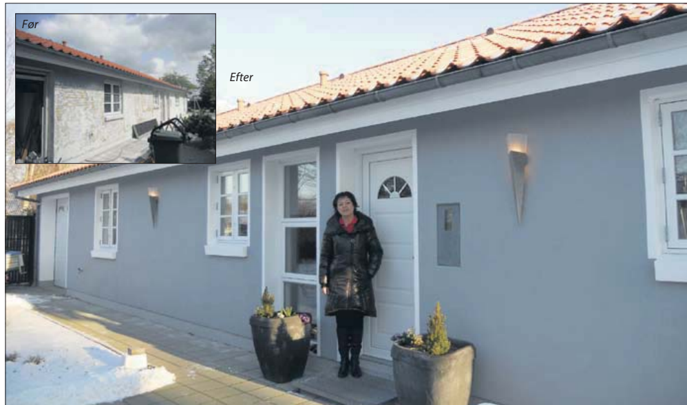
Lotte Gren, der har fået sit hus på Faldborggade 48 i Brovst facaderenoveret med net-armering, er en af de mange tilfredse kunder hos Nordisk Facade. – Det er en af mine bedste investeringer. Dygtigt, effektivt og professionelt udført arbejde, fastslår hun. Foto: Nordisk Facade
